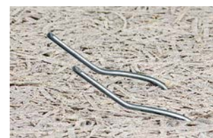
Vue de dessus, l'ancrage est fixé dans le béton
