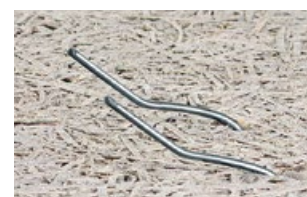
Vista del pannello dall'alto (l'ancoraggio verrà cementato)
